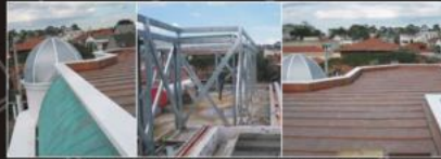
Junção de materiais e técnicas minimizou o custo da obra. Para o coroamento, foram usadas telhas losangulares de cobre patinado em tom verde e na parte central da cobertura foram aplicadas bandejas zipadas em cobre natural
